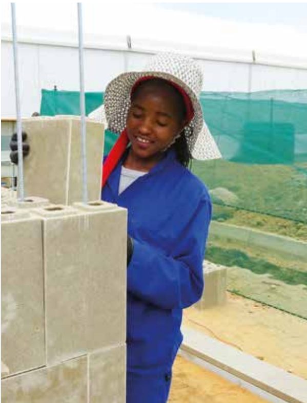
Die Firma PolyCare setzt auf eine innovative und nachhaltige Bauweise mit Polymerbetonsteinen.
